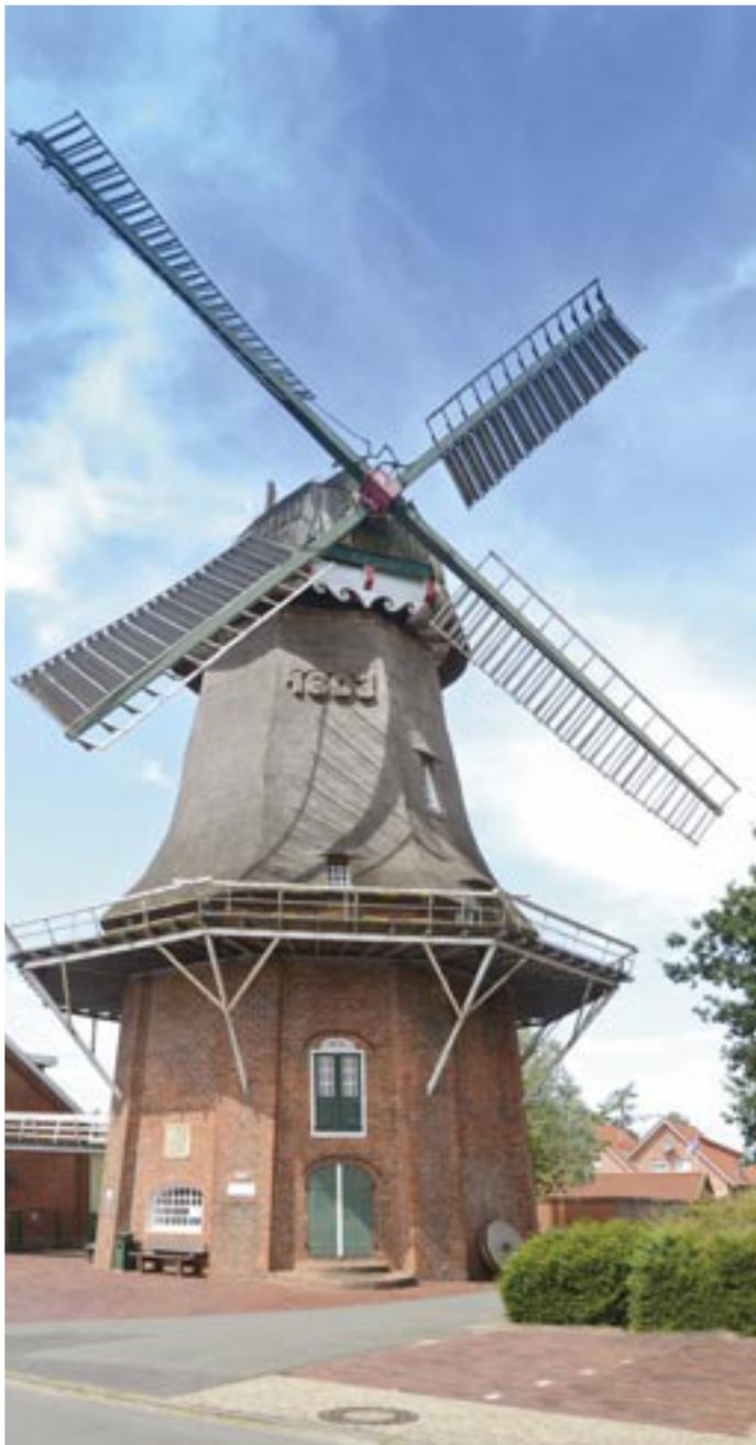
Die zweistöckige **Holländermühle in Großdendorf** wurde 1887 erbaut und verfügt über zwei nicht intakte Mahlgänge. Bis 1962 wurde sie mit Wind betrieben, danach bis 1977 mit Motorkraft. Äußerlich wurde sie restauriert. Heute befindet sie sich im Privatbesitz der Familie ter Veen.
